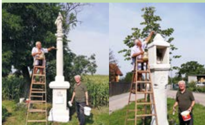
Sanierung der Kleindenkmäler
